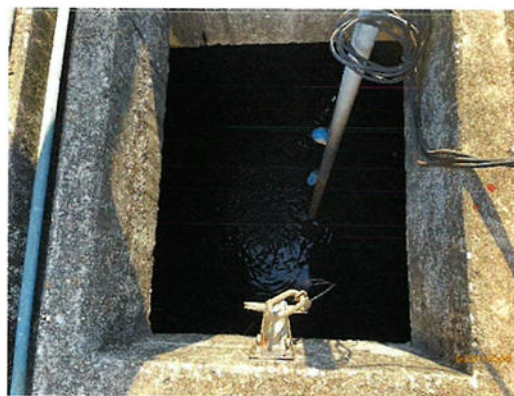
ภาพที่ 2.2-14 การเติมคลอรีนลงในน้ำทิ้ง
