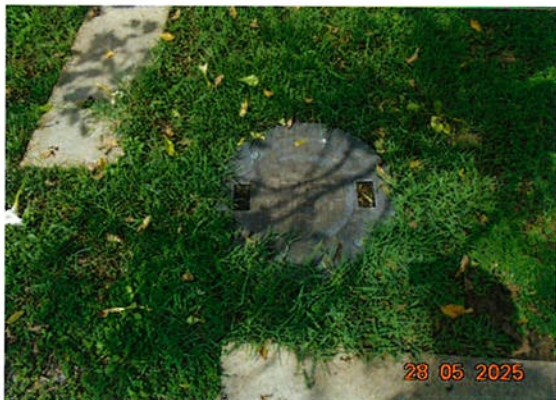
ภาพที่ 2.2-13 ถังบำบัดน้ำเสียสำเร็จรูป (Septic Tank)
