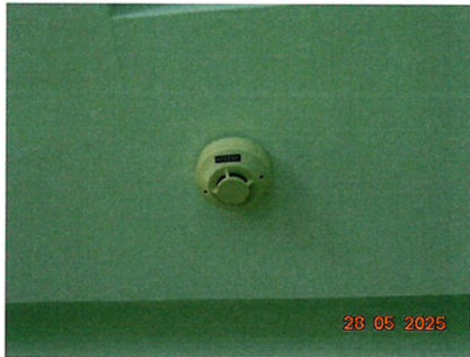
ภาพที่ 2.2-54 อุปกรณ์ตรวจจับควัน (Smoke Detector)
