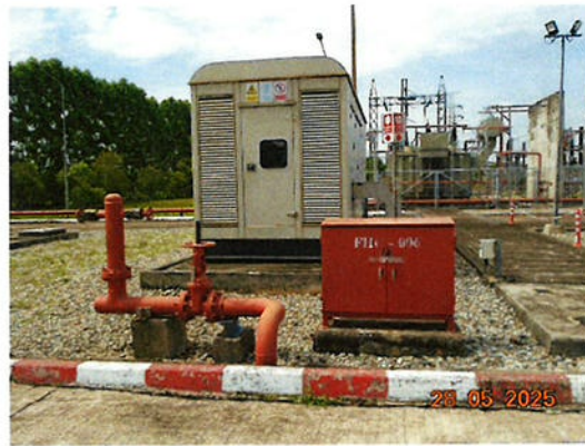
หัวฉีดน้ำดับเพลิง (Fire Hydrant)
