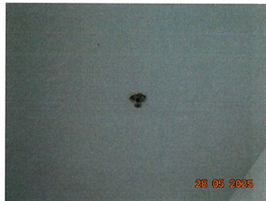
ภาพที่ 2.2-55 อุปกรณ์ตรวจจับความร้อน (Heat Detector)
