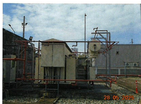
ภาพที่ 2.2-59 ระบบหัวกระจายน้ำดับเพลิงอัตโนมัติ (Deluge System)
