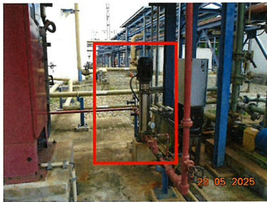
ภาพที่ 2.2-62 เครื่องสูบน้ำรักษาความดันน้ำดับเพลิง (Jockey Pump)
