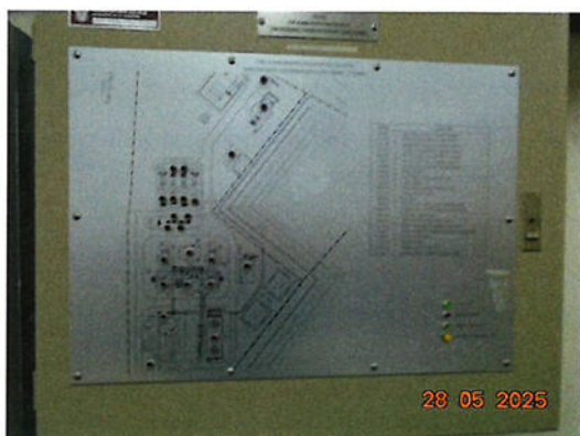
ภาพที่ 2.2-58 ระบบแจ้งเตือนเหตุเพลิงไหม้
