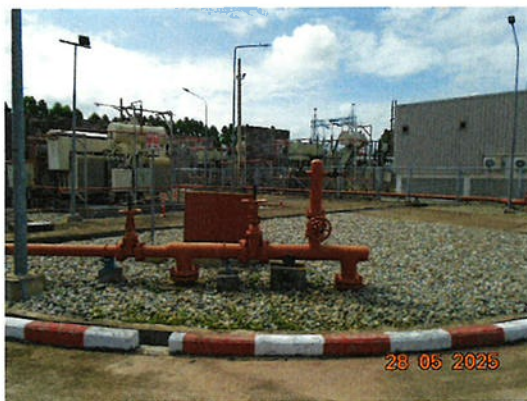
หัวฉีดน้ำดับเพลิง (Fire Hydrant)
