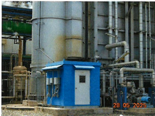
ภาพที่ 2.2-3 ระบบ CEMs ของปล่อง HRSG#12
