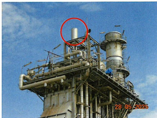
ภาพที่ 2.2-7 Silencer ที่ Safety Valve
