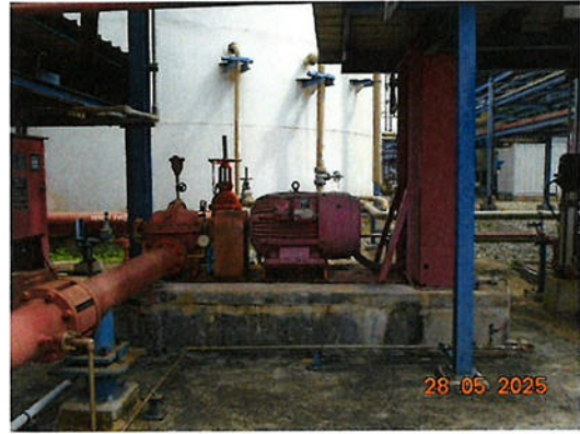
ภาพที่ 2.2-61 เครื่องสูบน้ำดับเพลิงสำรอง
